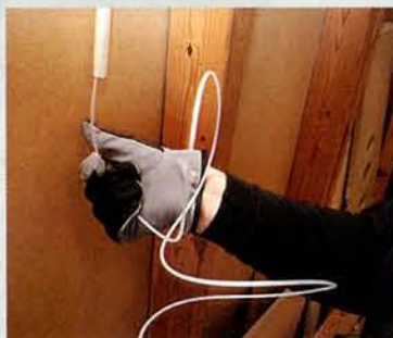
Opalin työntäminen putkeen oli hankalaa ja jousi meni käytettäessä nopeasti sekaisin.
