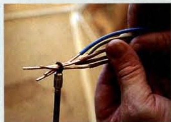
KM 88:n silmukan sisään saatiin viisi ML-johdinta.
