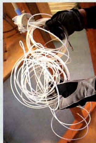
Opalin työntäminen putkeen oli hankalaa ja jousi meni käytettäessä nopeasti sekaisin.
